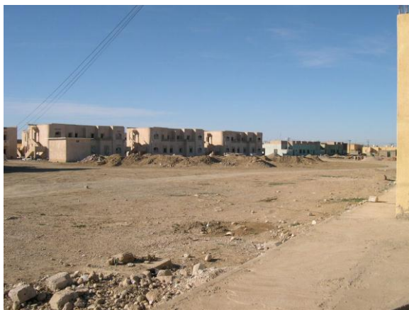
Le dernier programme de logements ruraux, initié par une nouvelle équipe de gestionnaires de l'APC. (2004)
