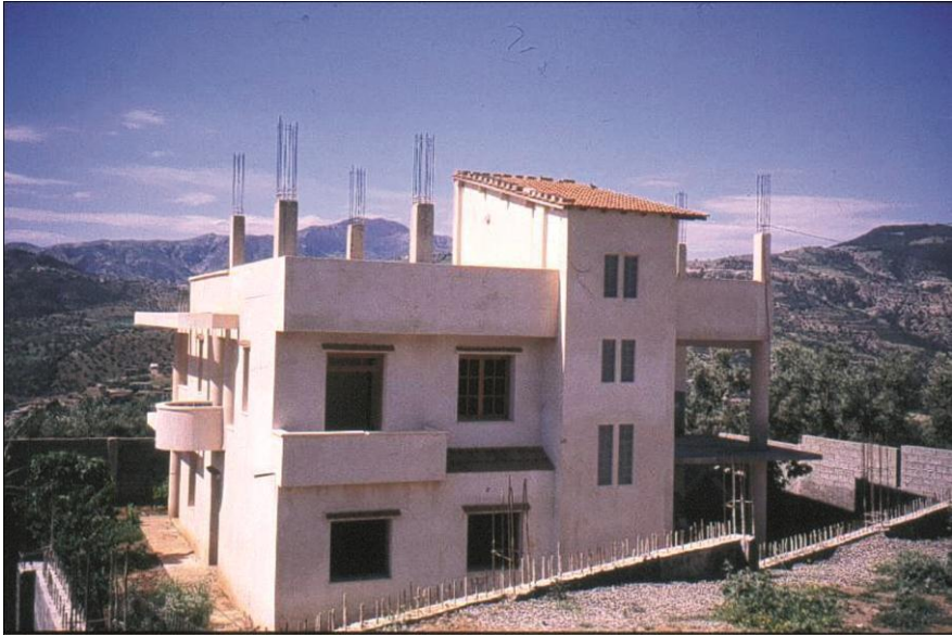
Fig n°08 : Vue d'une maison du 3° âge
